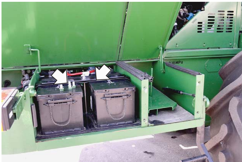
Рисунок 3.78 — Расположение аккумуляторных батарей
